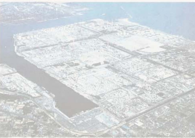
コンビナートの高圧設備の耐震基準の見直しに着手(鹿島東部コンビナート)
